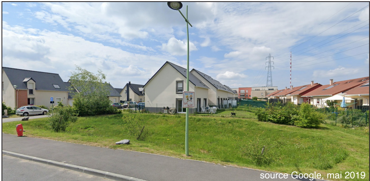
Figure 11 : Exemple de noue en secteur résidentiel (Grand-Couronne)
